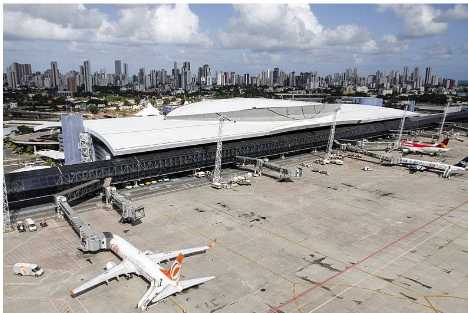
Figura 25: Aeroporto Internacional de Guararapes
